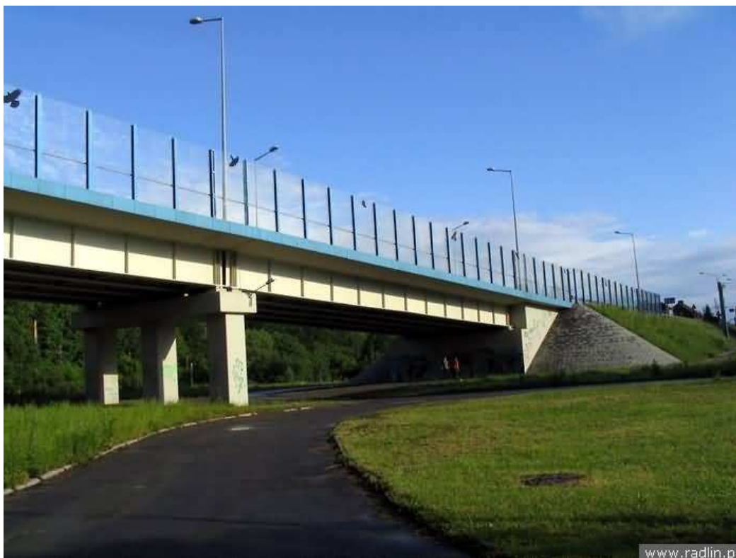
Most na ul. Rybnickiej
