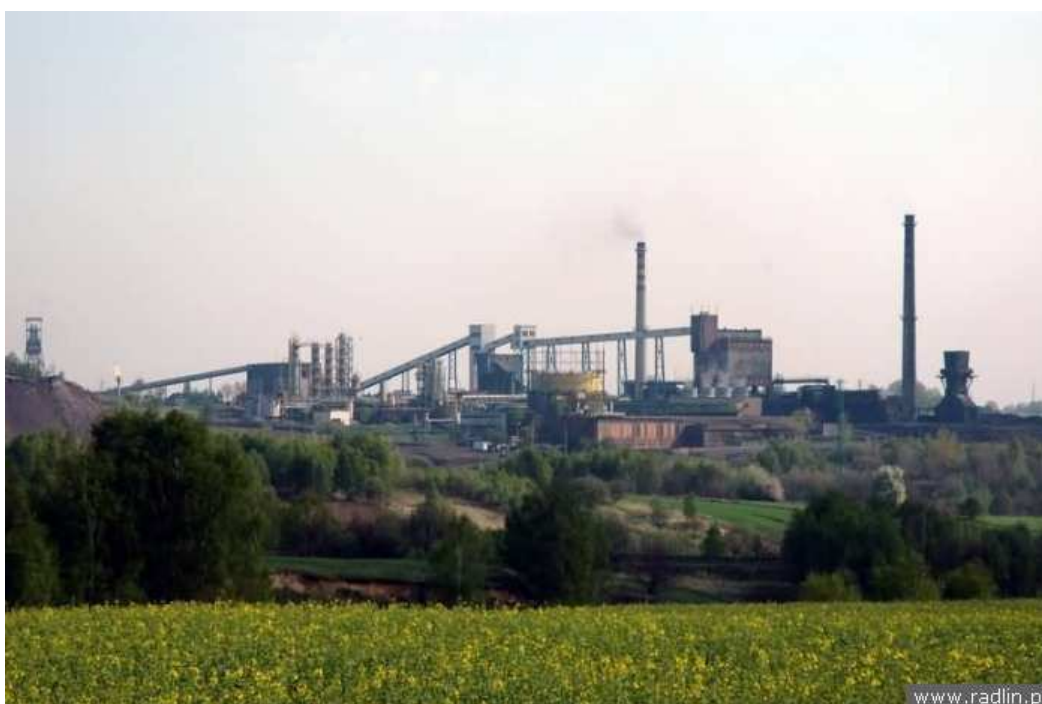
Widok na Zakłady Koksownicze i Kopalnię MARCEL
